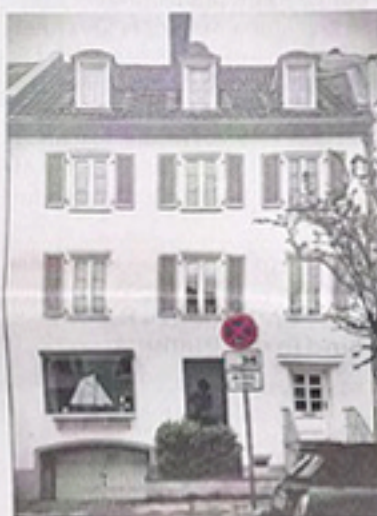
Das Haus der Columbusstraße wird abgerissen, obwohl es gut aussieht.
