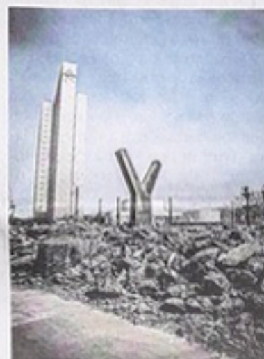
2013 wurde der Tausendfüßler in der Innenstadt abgerissen.
